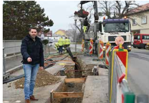
Neue Strom-Leitungen werden eingezogen
