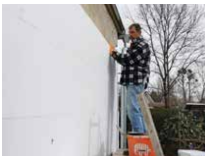
Große Hilfe bei der Fassade
