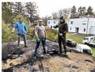
Fleißige Helfer am Dach
