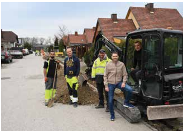
Rund 15 Kilometer Straßennetz wurde mit Glasfaserkabel ausgestattet. Bürgermeister René Klimes schaute bei der Baustelle in der Heidegasse in Blumau vorbei, um sich selbst ein Bild vom raschen Arbeitsfortschritt zu machen.
