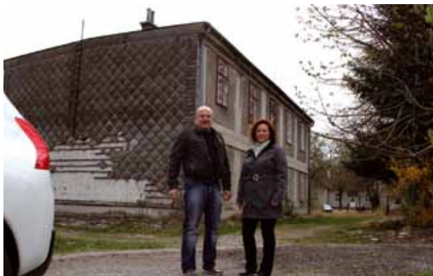
Der Denkmalschutz für die beiden Häuser in der Kasinostraße ist endlich Geschichte.
