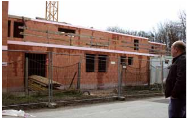
Die Arbeiten auf der Baustelle schreiten zügig voran.
